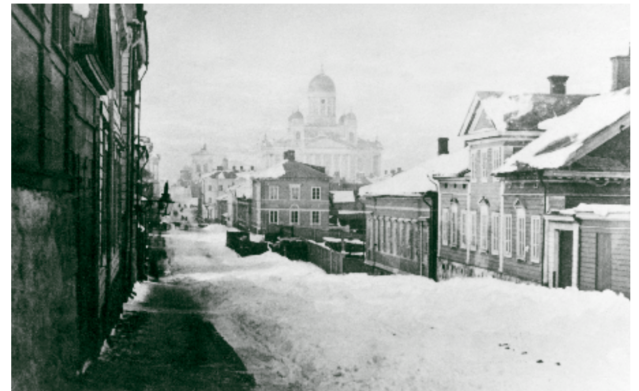
Oikealla keskellä on Diakonissalaitoksen ensimmäinen toimipaikka, yksikerroksinen puutalo Unioninkadulla. Kuva on otettu vuonna 1866.
